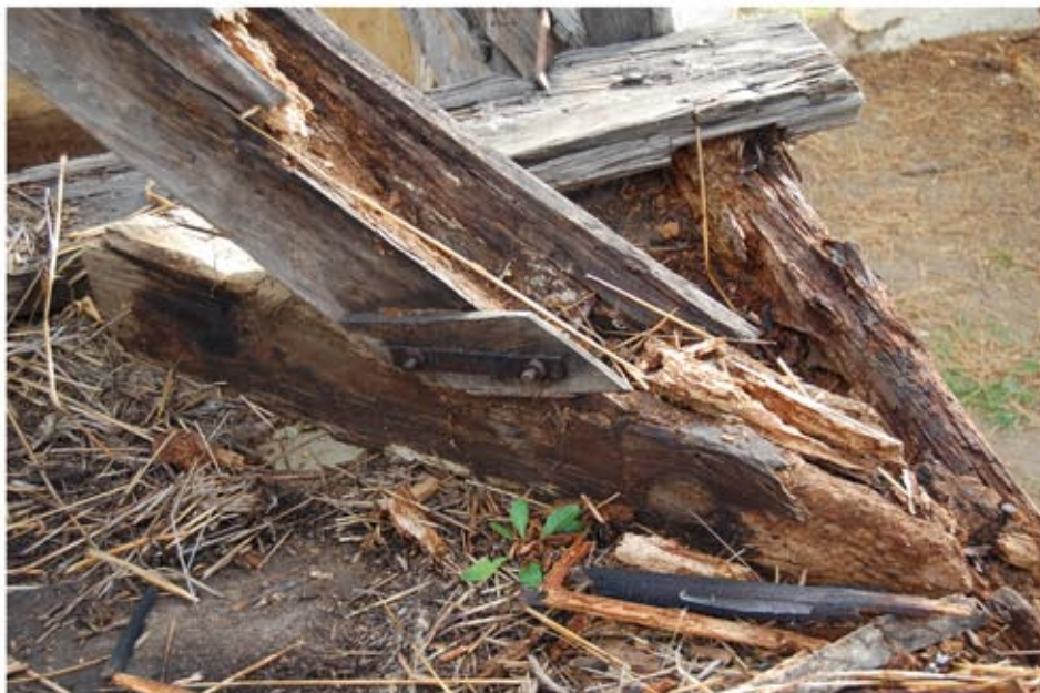
Megroppant szerkezeti elemek feltárás közben.
