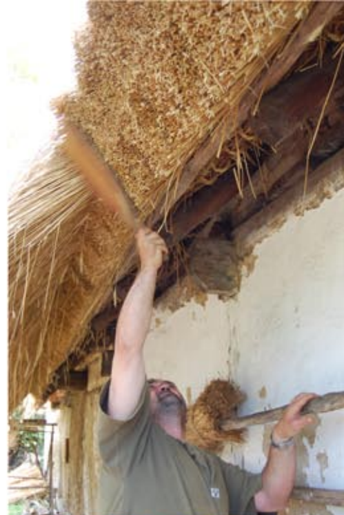
Az ereszalja levágása, a zsúp felverése
