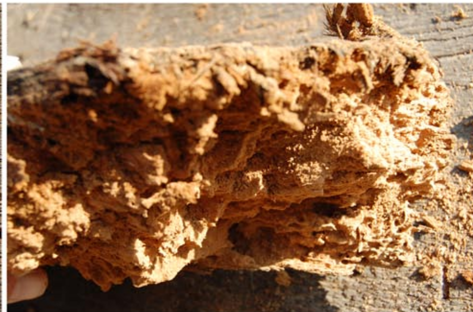
Erősen rovarfertőzött szerkezeti elemek a konyha mennyezetén
