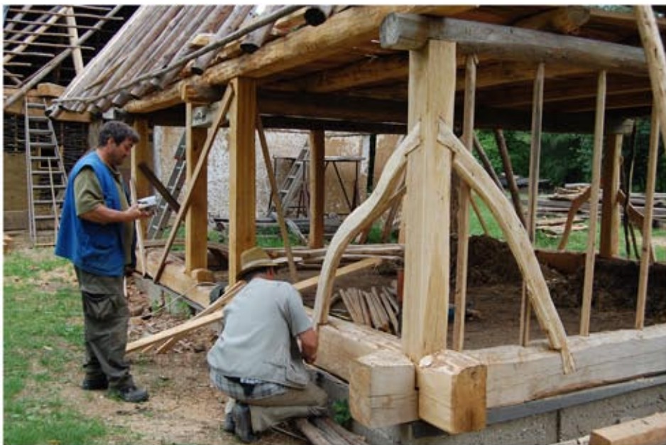
Az istálló vázszerkezetének rekonstrukciója faragott tölgyfából
