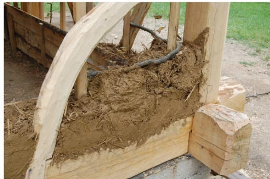
Karóközös sárfal készítése az új vázszerkezetben
